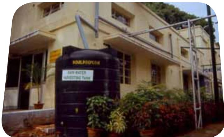
شكل ٢. خزان بلاستيك لجمع مياه الأمطار لاستخدامها في الأغراض المنزلية
