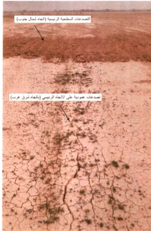
شكل رقم 7: صورة ميدانية توضح التصدعات السطحية باتجاه شرق-غرب.
